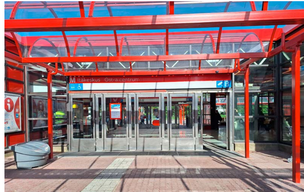
Lippuhallirakennuksen sisäänkäynti. Kuva: AM.
