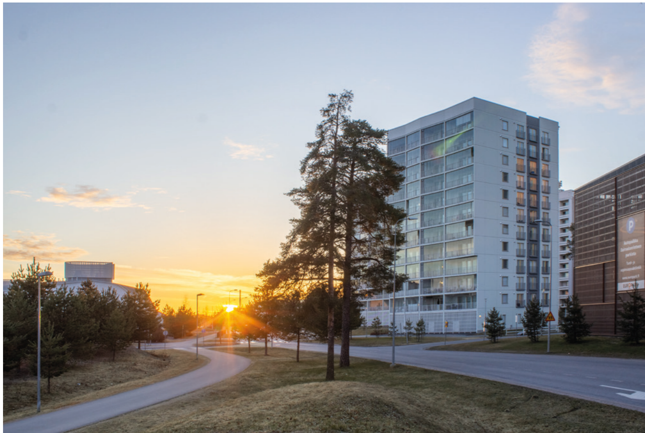
Kuva 11. Näkymä Sairaalanrinteeltä luoteeseen.
