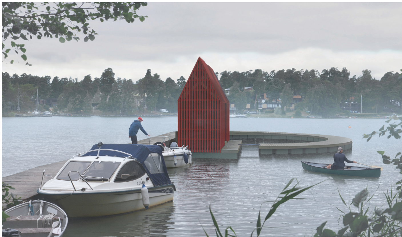
kelluva huoltohytti vessalla / floating cabin with toilet
