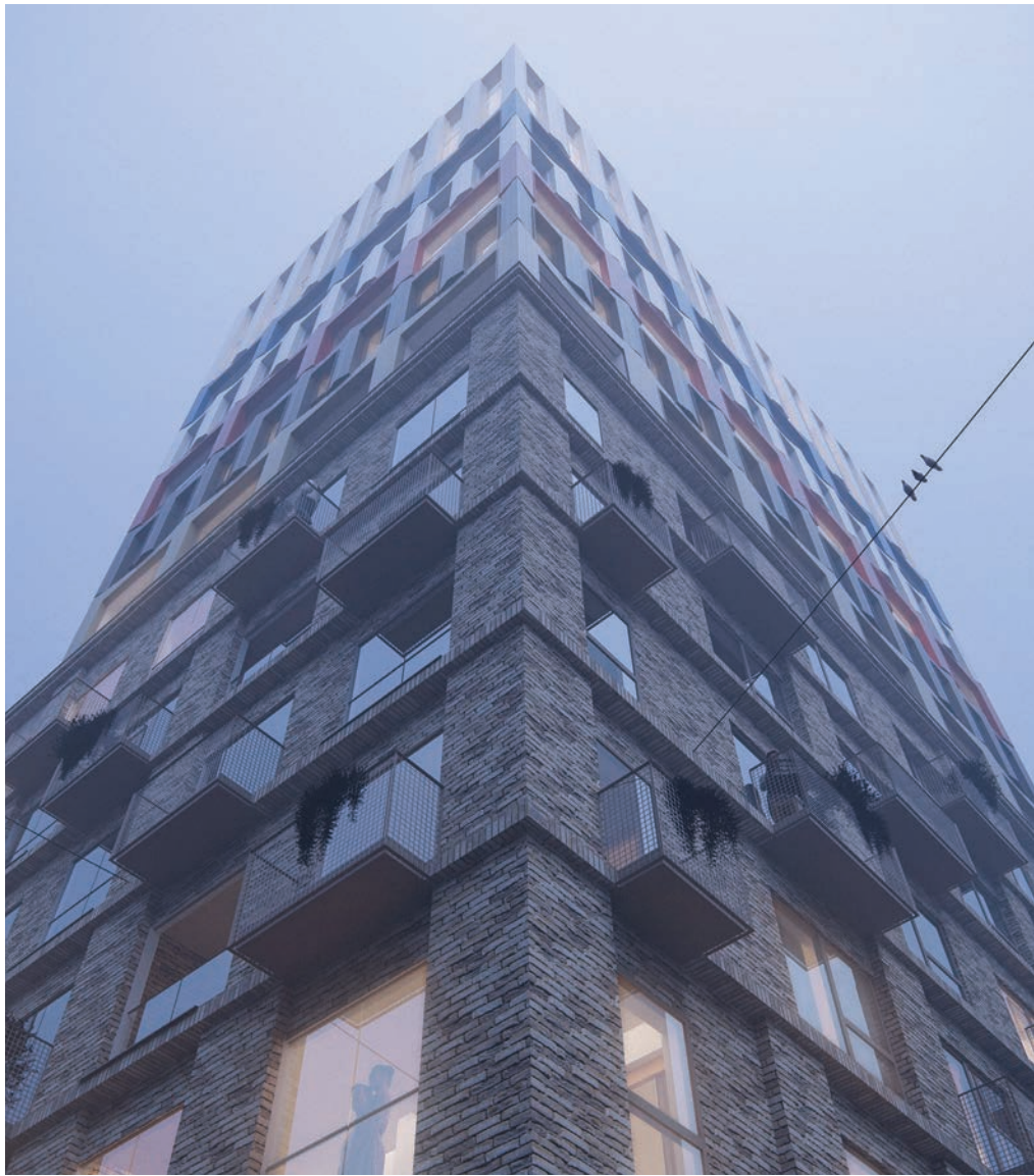
Näkymä katutasosta tornin huippua kohti korttelin kaakkoiskulmassa
