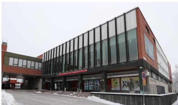
Teatterirakennus ulkoa. (Kouvolan kaupunki 2023)
