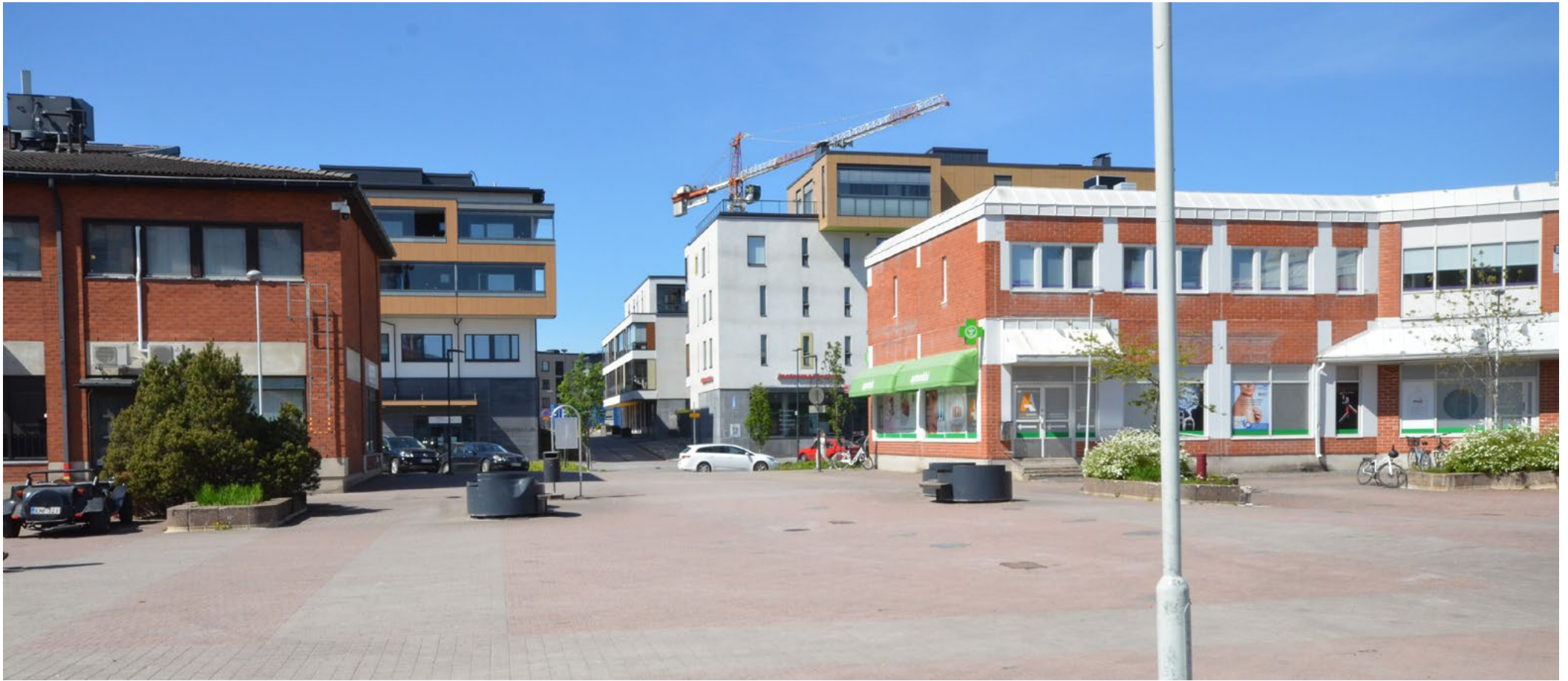
Näkymä entisen torin alueelta liikerakennusten (1985 ja 1988) välistä LPA-alueelta (entinen tori) uudelle korttelille Keskusta täydentyi kahdella matalalla, silloista toria sisäpihamaiseksi rajaavalla liikerakennuksella (1985 ja 1988). Kilpailualueen itäreunassa on 1970 rakennettu tehdasrakennus, joka nykyään toimii market-tyyppisenä kauppana.
