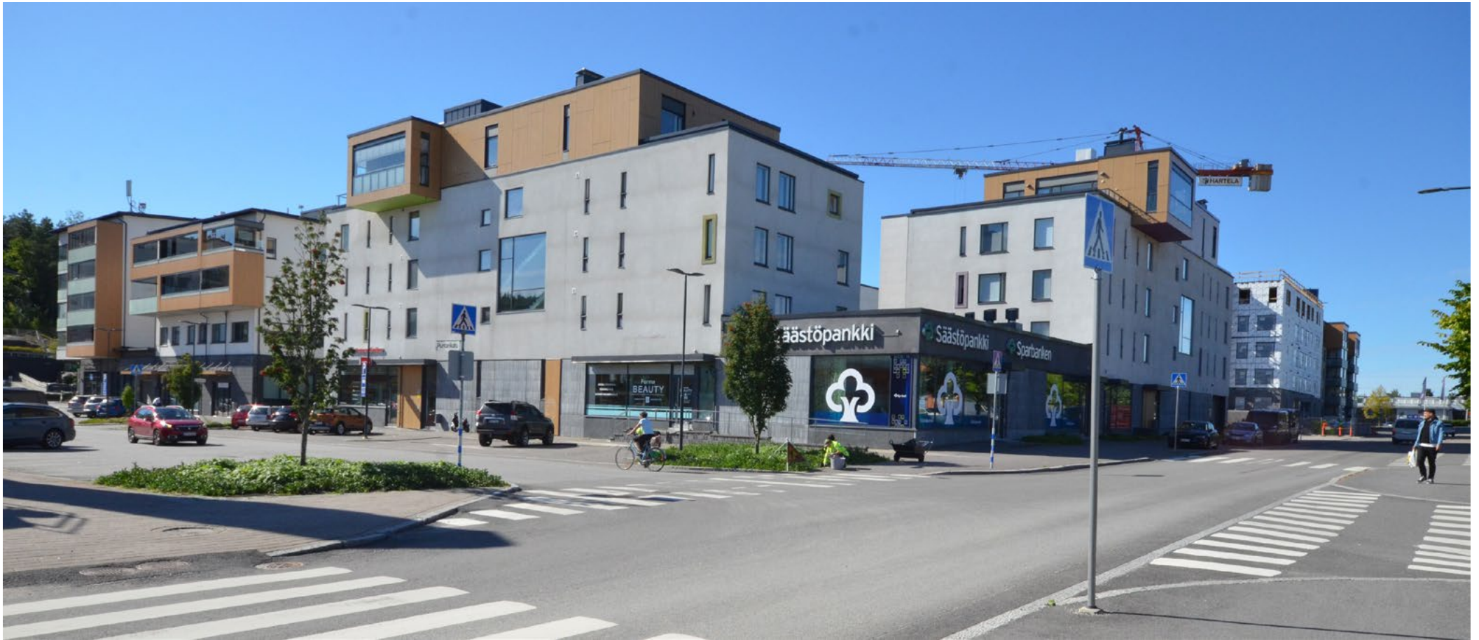
Uusi kortteli Pyhän Katariinan tien ja Lautakunnankadun välissä
