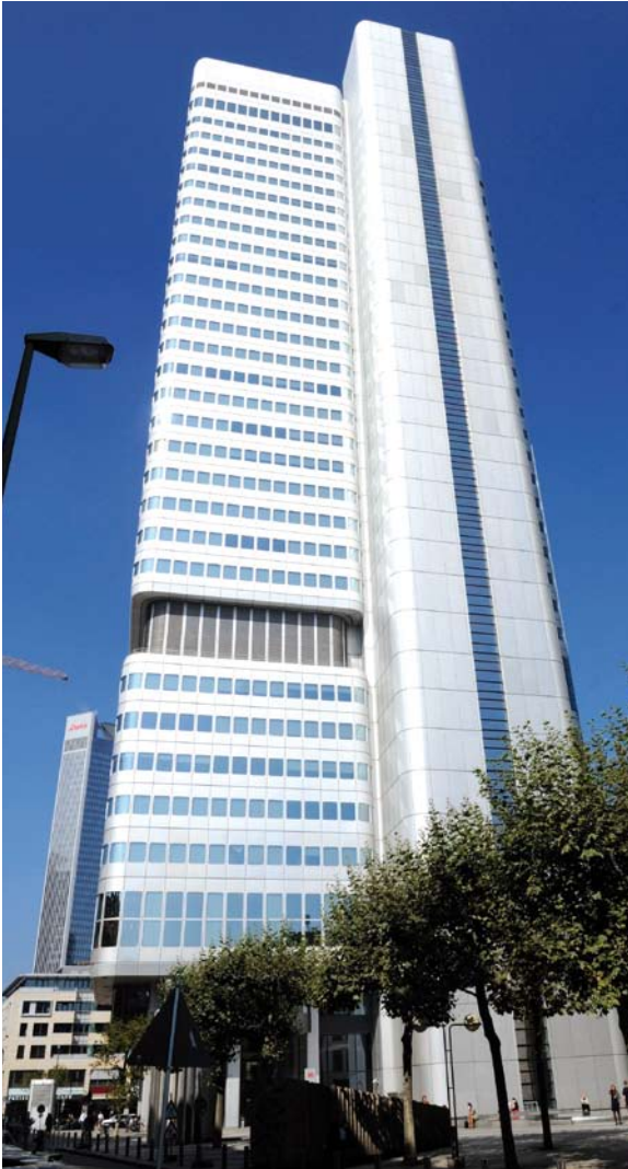
Arkkitehti Richard Heilin vuonna 1972 suunnittelema ja vuonna 1978 valmistunut Silberturm-pilvenpiirtäjä säilytti energiaremontissa tyylinsä, mutta se kuluttaa nyt kolmanneksen aiempaa vähemmän energiaa.
