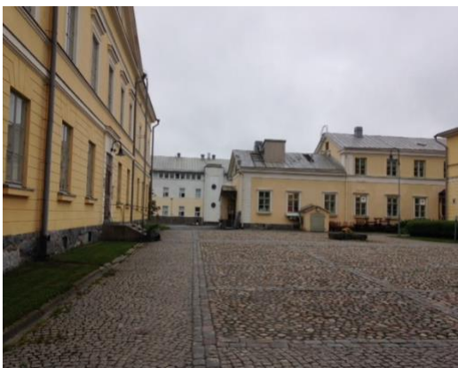
Rakennuksien F ja T väli etelään.
