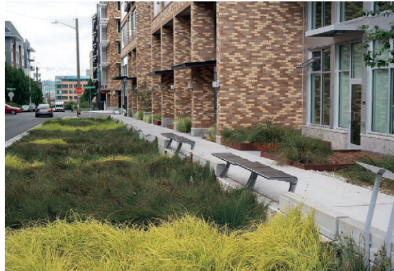
Seattlen Yalen alue on viimeisimpiä toteutuneita hulevesien hallinnan "retrofitting"-kohteita keskustassa.
