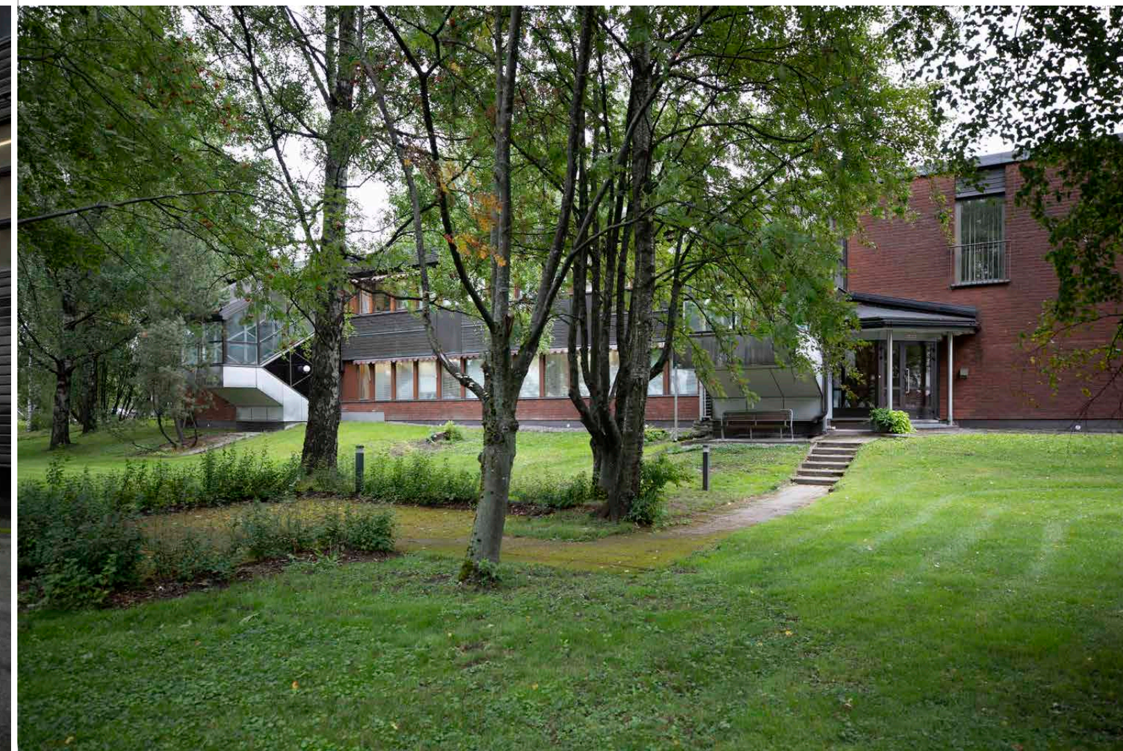
Jälkikäteen lisätyt portaikot konttorirakennuksessa näkyvät sisäpihan puolella.
