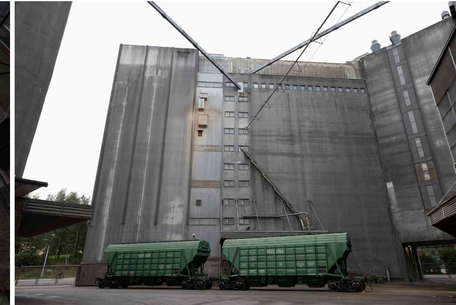
Uuden siiloston seinämä Polttimon sisäpihan suuntaan.
