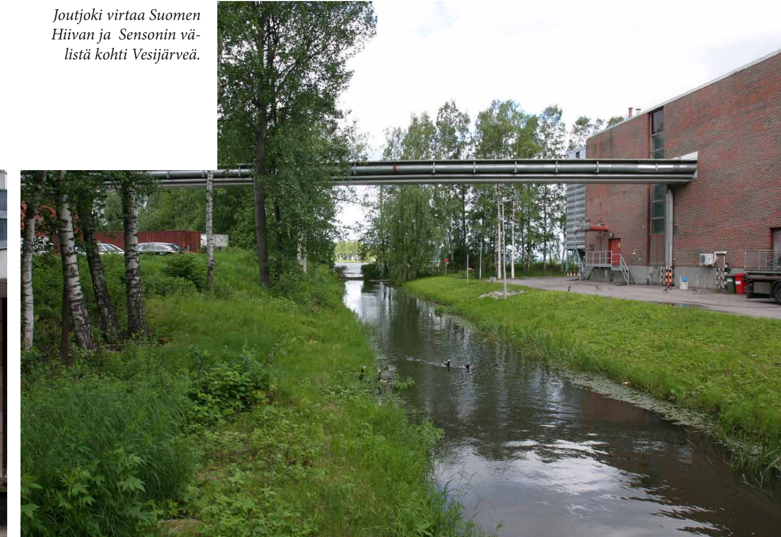
Näkymä uudelta hiiva-tehtaalta etelään kohti korjaamorakennusta. Taustalla näkyy mallastomurakennuksia ja niiden takana kohoavat uudet viljasiilostot.
