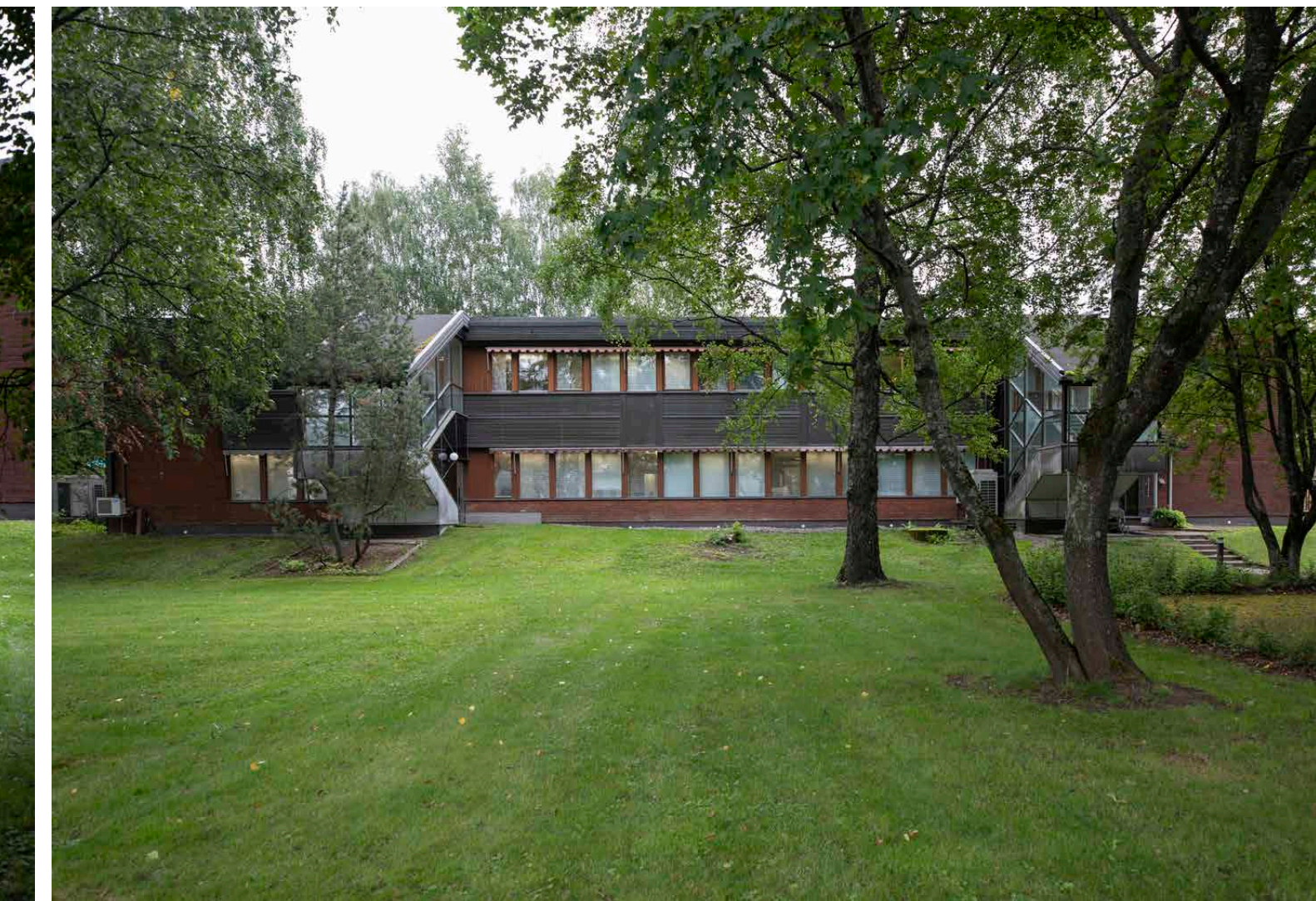
1960-luvulla rakennettua konttorirakennusta on korotettu 2. kerroksella 1980-luvulla.
