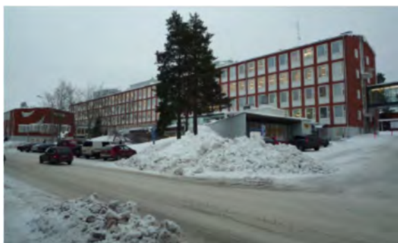
12 Ammattioppilaitoksen päärakennus (A)
