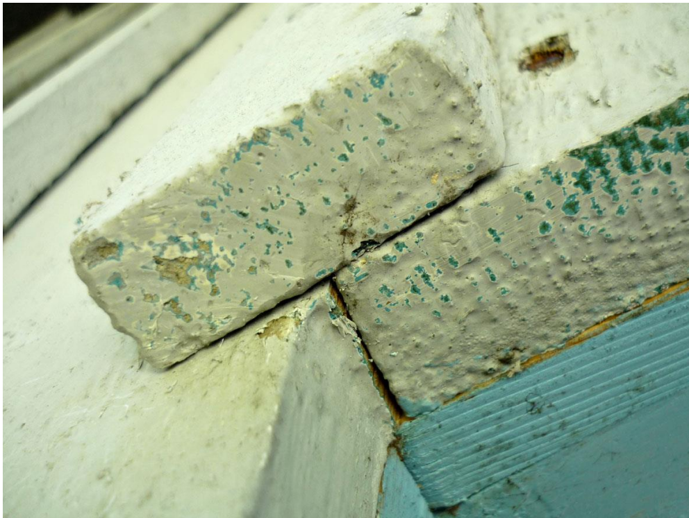
Porttikongin värirajaus on muuttunut alkuperäisestä: vaaleansininen on alunperin jatkunut aukon ulkosärmään saakka. Näin sisäpihalta ulos katsottaessa on näkynyt vain sisäpihan vaaleansinistä eikä lainkaan ulkopuolen harmaata.
