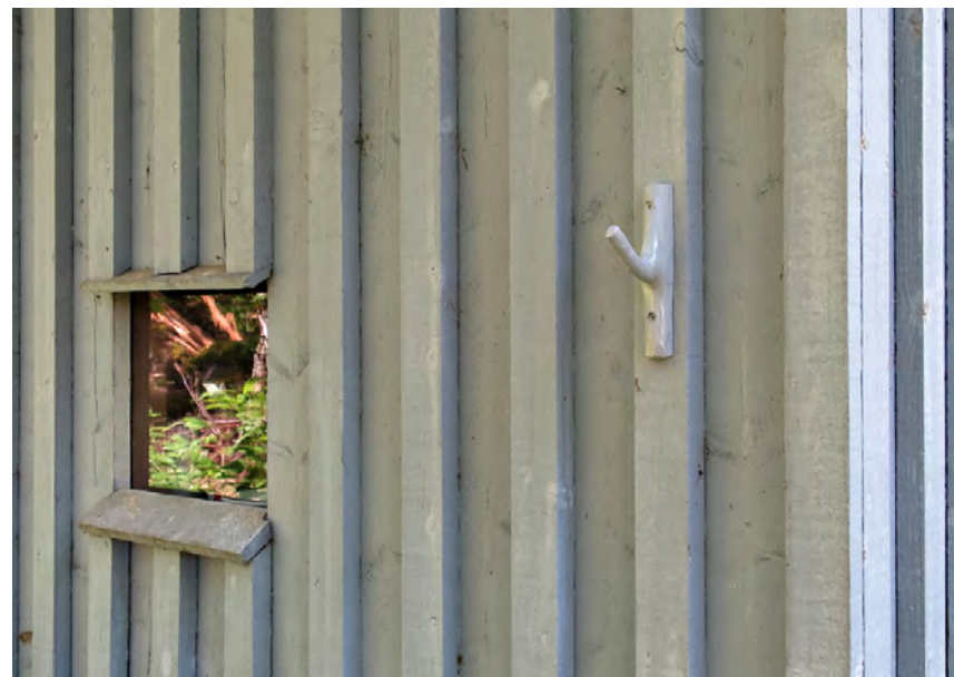
Ulkohuoneen seinään lisättiin käsipyyhettä varten kuusen oksanhaarasta veistetty koukku, jollainen oli jäänyt yli vuoden 2015 saunankunnostuksesta. Koukku kiinnitettiin Torx-kantaisilla ruuveilla ja maalattiin pellavaöljymaalilla.
