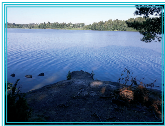
Kuva 2: Vanhan laiturin betoniperusta
