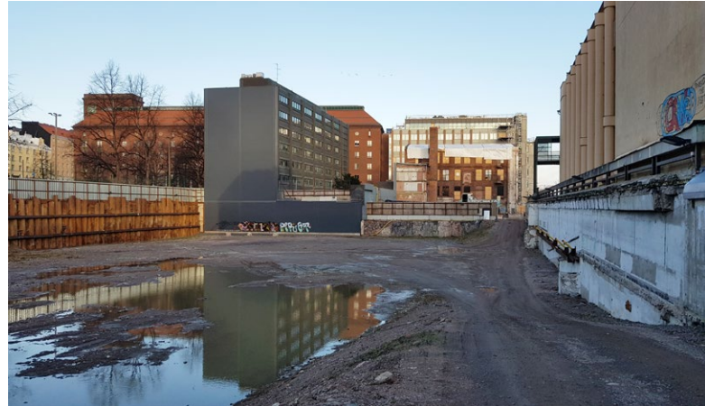
Kilpailualueelta on aiemmin purettu virastorakennus.
