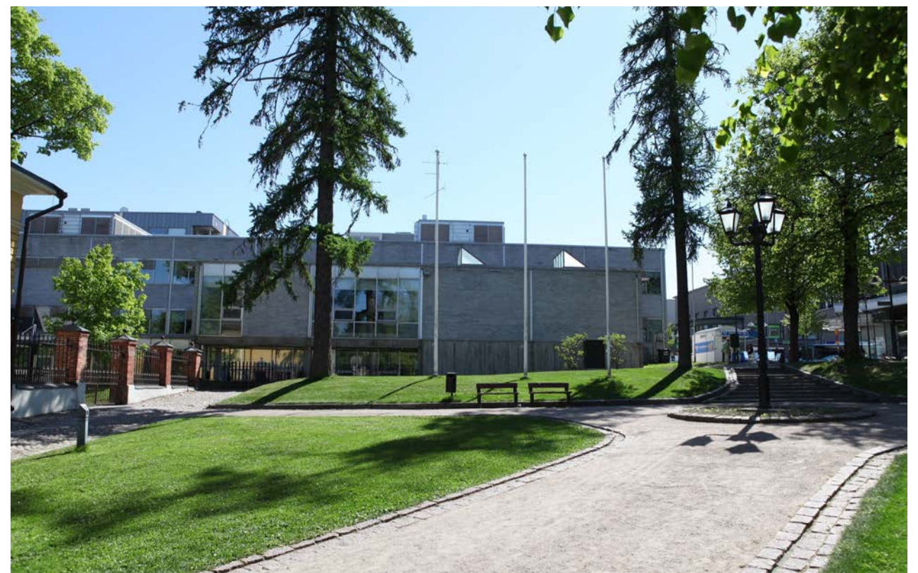
NÄKYMÄ KILPAILUALUEELLE: PUISTOA JA SEURAKUNTAKESKUS.
