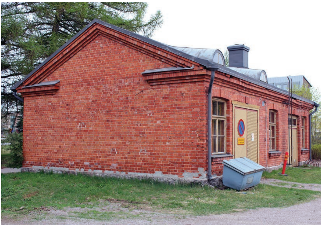
Kilpailutontilla sijaitseva suojeltu punatiilinen varastorakennus
