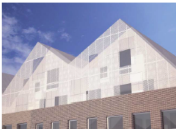
Parvekkeen ylempien kerrosten metalliverkkorakenteesta
