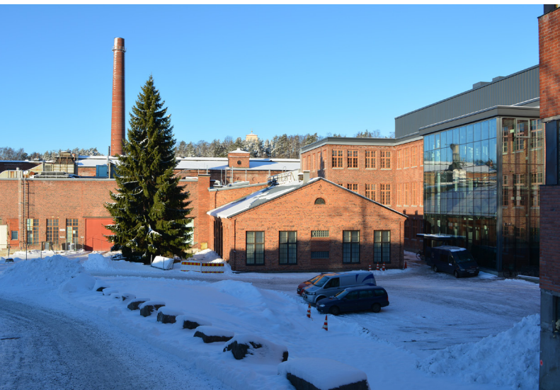
Vanhaa paperitehdasta, oikeassa reunassa Luovan kampuksen siipi
