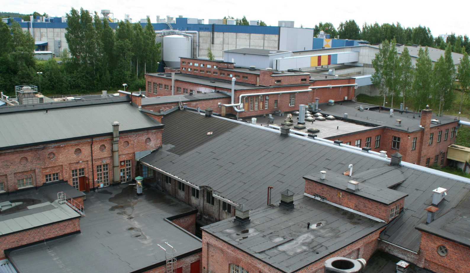
Kankaan alueen vanhoja tehdasrakennuksia
