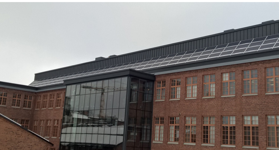
Aurinkopaneelit vanhan paperitehtaan siipirakennuksen, Luovan kampuksen, katolla
