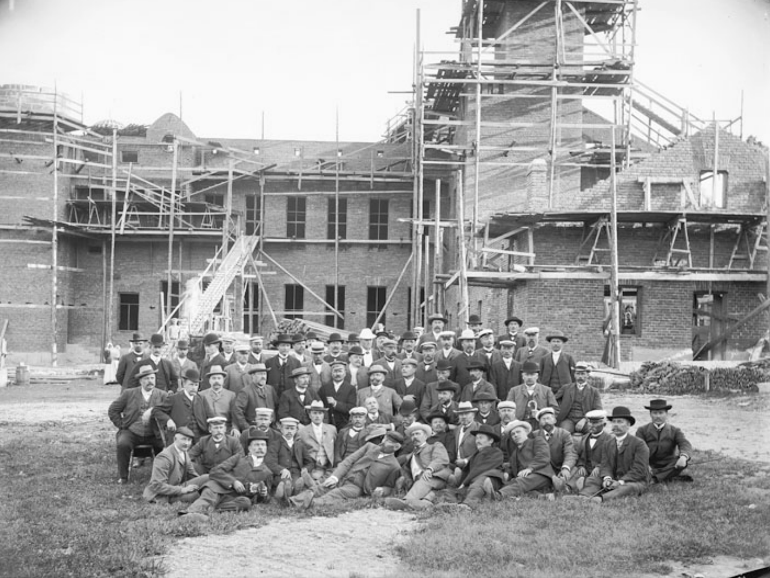
Rakennusmestarit Kuopion museon rakennustyömaalla 1906 (KHM, Viktor Barsokevitsch)
