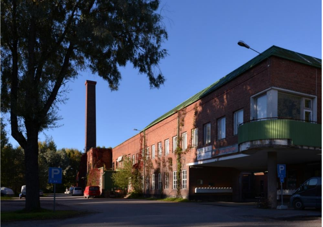
Kuva 4. Mensa Oy:n vanha tehdasrakennus (2-III), rakennusvaihe III.
