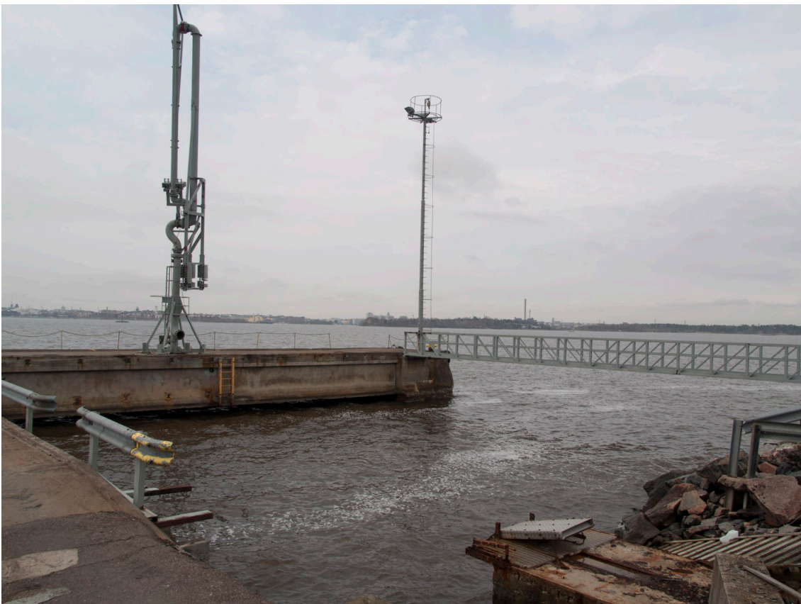
Laiturin teräsrakenteinen silta.
