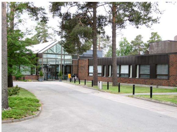
Pohton pääsisäänkäynti pohjoisen puolella.
