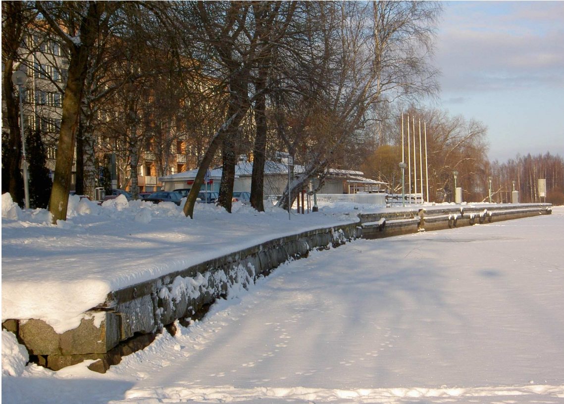
Rantapuistoa ja Laivarantaa helmikuussa 2007. Laivarannan matkustaja-alusten laiturin ja Rantapuiston rantamuurin nivelkohta näkyy korkeuserona. Kuva: Antti Kaukia
