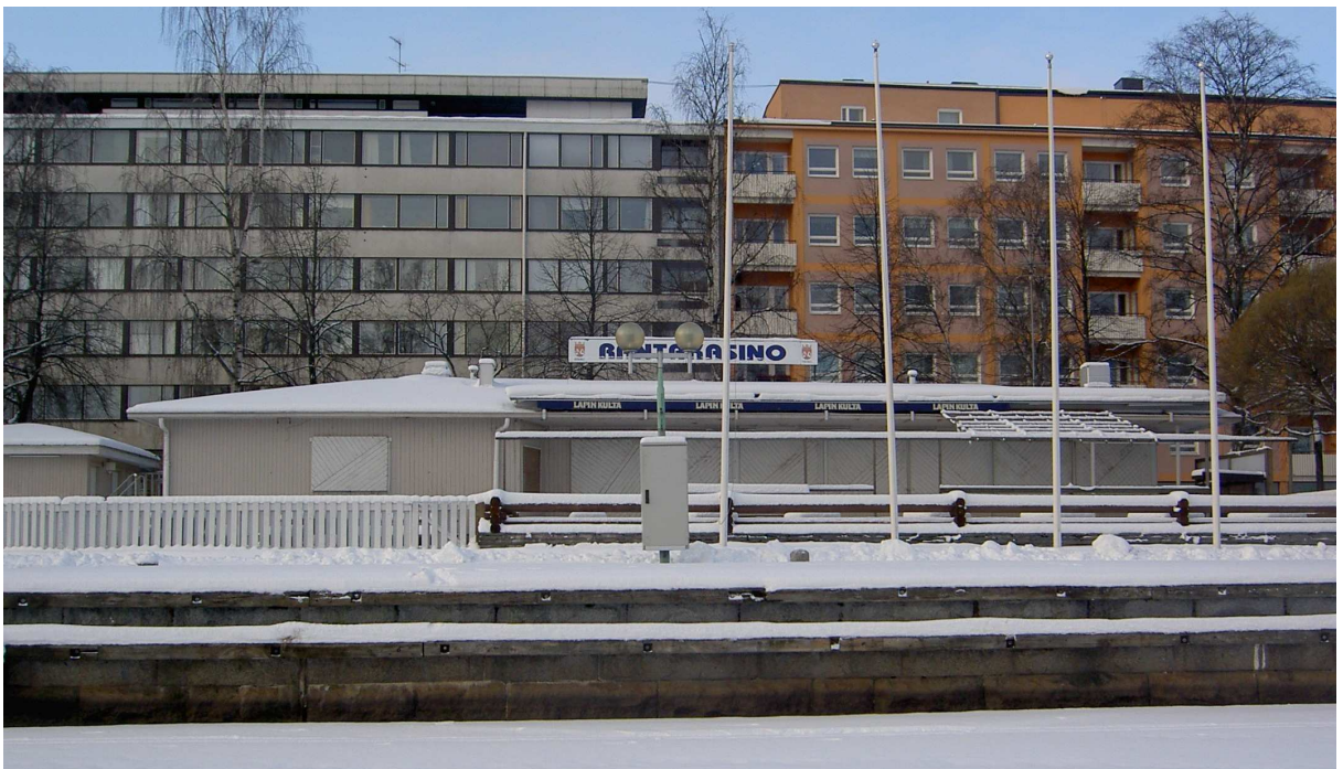
Laivarannan paviljonki ja laituri helmikuussa 2007. Paviljongin vasemmalla puolella näkyy osa kioskirakennusta, taustalla Arvi Kariston kadun kerrostaloja. Kuva: Antti Kaukiainen
